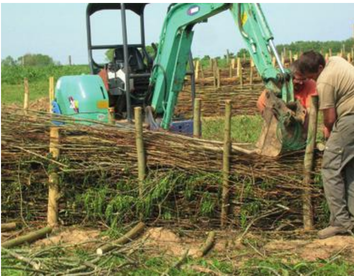
Mise en place de fascines en contexte agricole.
