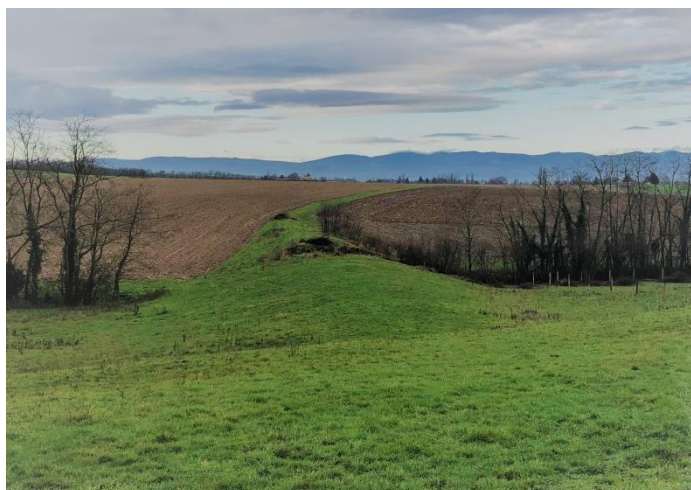
Photo 2 : Aménagement hydraulique du ruisseau des Prades (affluent de la Mâtre) – Décembre 2018 Source : SRDCBS
