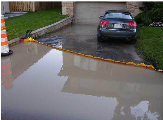
Ci-dessus : exemples de dispositifs individuels de diminution des entrées d'eau Barrière souple anti-inondation (à gauche ) et batardeau amovible (à droite)
