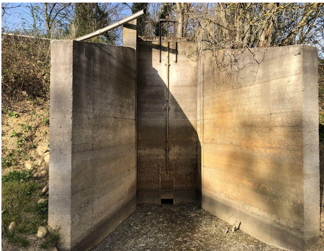
Photo de la vanne de
